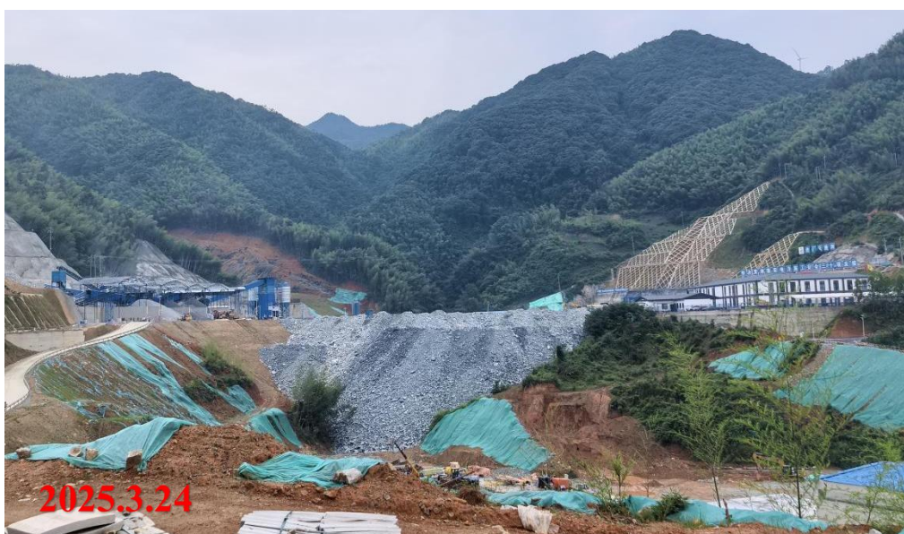
图 4.5-1 下库中转堆料场现状照片
