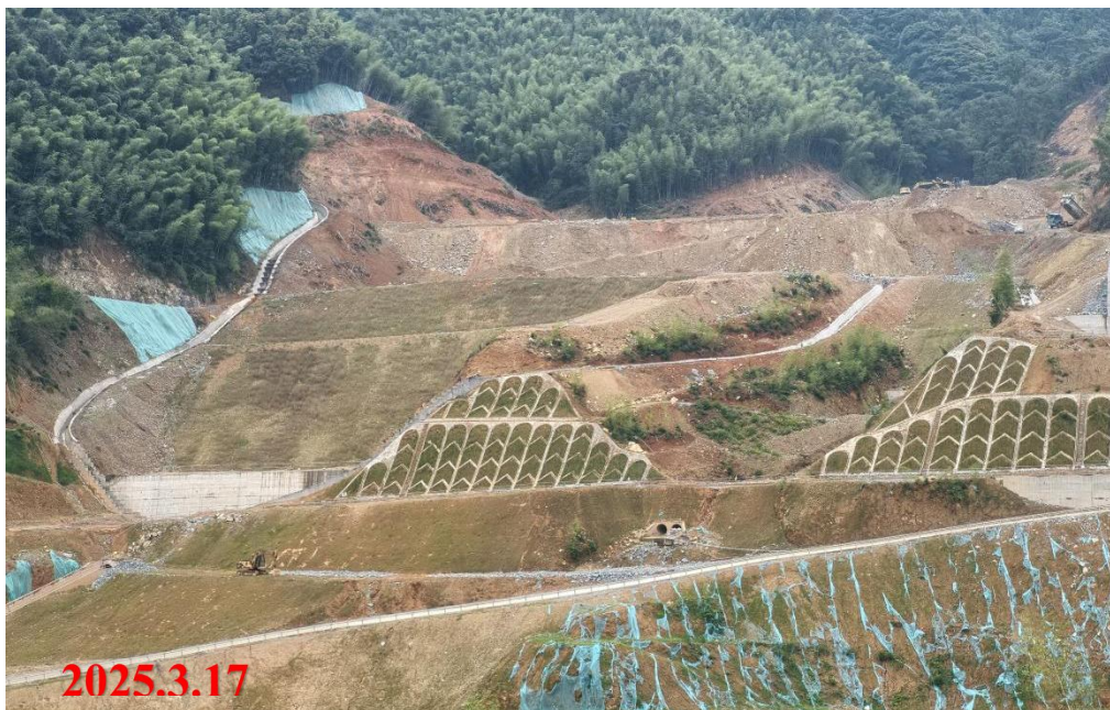
图 4.2-1 下库 1#弃渣场现状照片
